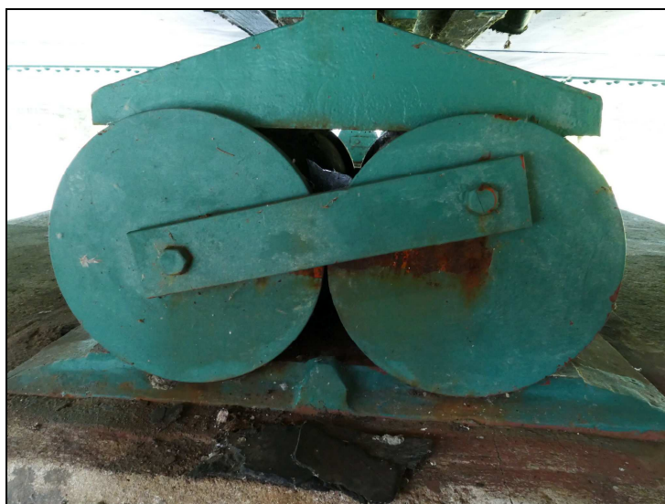
Obr. č. 3 – Konstrukce K 01 – pravé ložisko na pilíři P 02 – utržený šroub v upevnění spráhla z vnější strany
