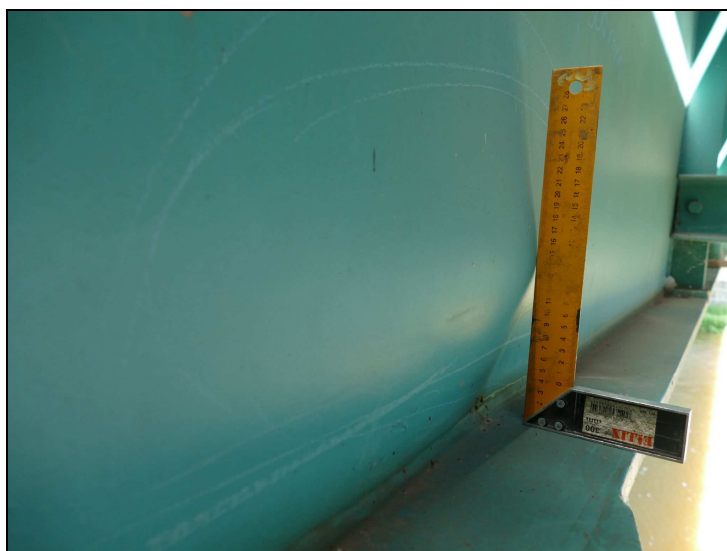
Obr. č. 2 – Konstrukce K 01 – deformace pravé stěny nosníku v 16 poli
