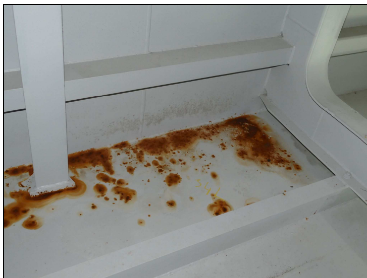
Obr. č. 1 – Konstrukce K 01 – porušená PKO ve 34 poli
